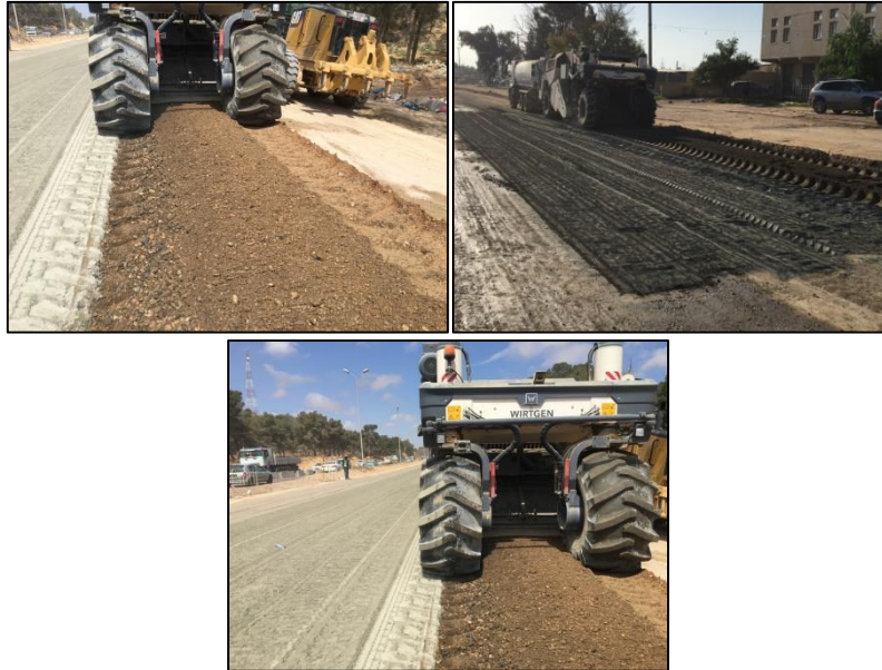
شكل رقم 10 عملية التفكيك والخلط.
